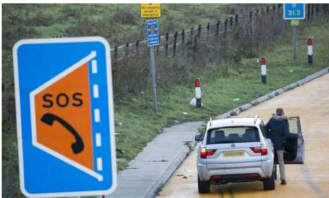
Figura 1: Baía de emergência em rodovia no Reino Unido.
