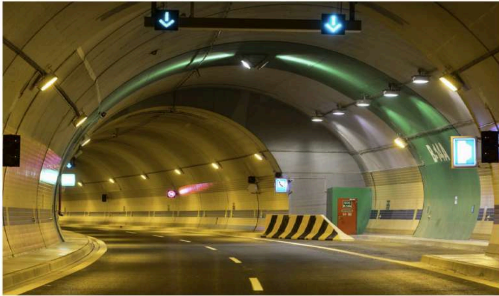
Figura 2: Baia do Complexo de Túneis Blanka, na cidade de Praga.
